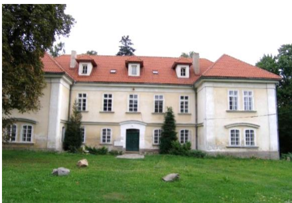
Obrázek 4: Zámek Nebřenice před a po rekonstrukci
