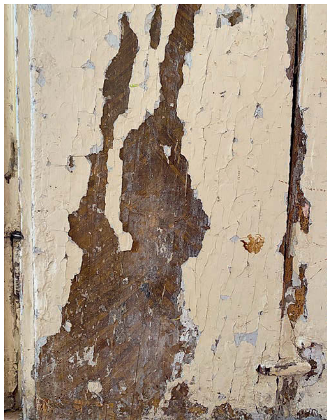
Obr. 21: Fara, přízemí, nátěry deštění dveří ze síně do světnice, pohled ze západu (foto K. Loub, 2024).
