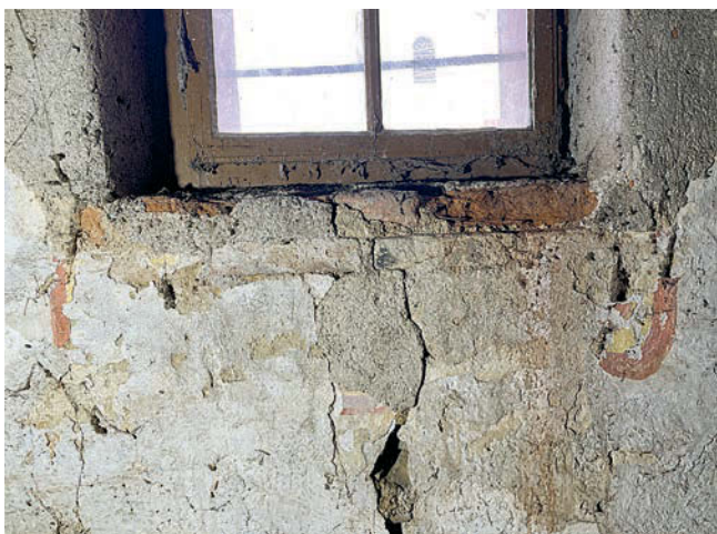
Obr. 15: Fara, podkroví, malovaná čabraka pod západním oknem severního štítu, pohled z jihu.
