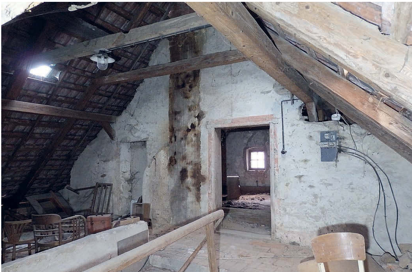
Obr. 11: Fara, podkroví, pohled na příčku severní prostoru, pohled z jihozápadu, stav 2023.
