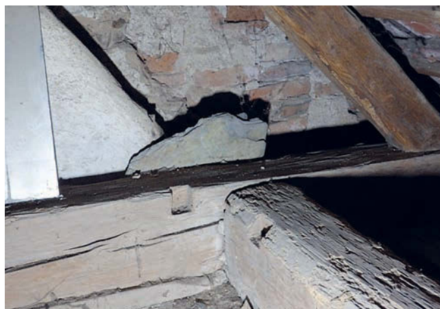
Obr. 17: Fara, podkroví, dlabý po zaniklé laťové konstrukci, cihelná nadezdívka severního štítu, pohled z jihozápadu.
