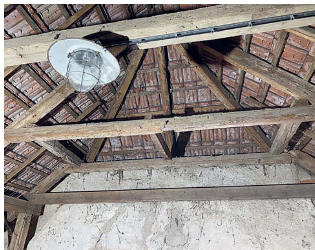
Obr. 27: Fara, podkroví, severní štít a pohled do krovu (foto K. Loub, 2024).
