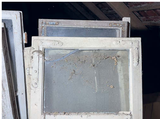
Obr. 24: Druhotně použitý barokní koutový závěs a rohovník na okenním křídle, pravděpodobně z rekonstrukce v roce 1872, dnes deponováno na krovu chléva.
