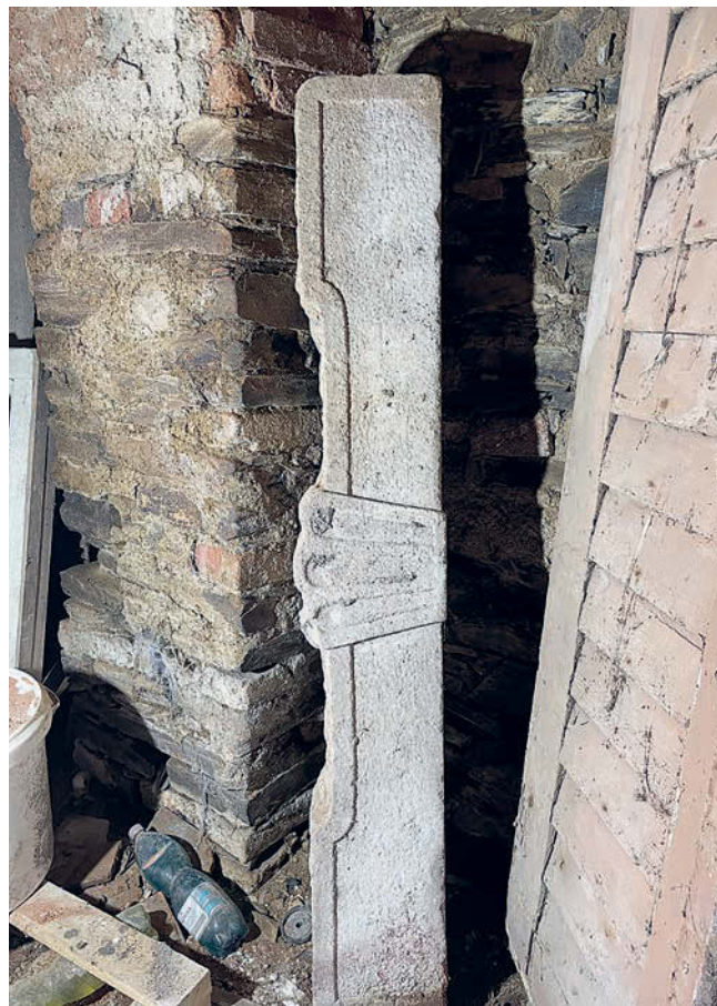
Obr. 26: Kamenný barokní překlád ze vstupu do fary, dnes deponován v nejnáchodnější prostře chléva.
