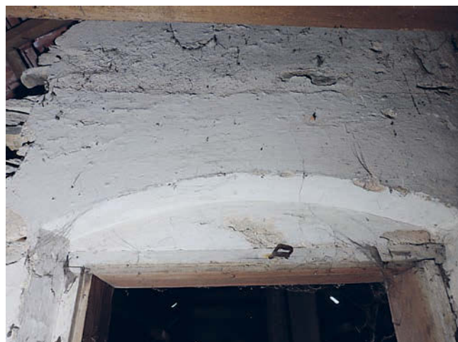
Obr. 14: Fara, podkroví, otisk zaniklé dřevěné klenby nad záklenkem vstupu, pohled od severu, stav 2023.
