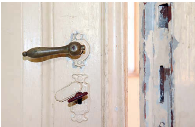
Obr. 22: Fara, přízemí, příklad většinou zastoupeného dveřního kování, pravděpodobně z rekonstrukce v roce 1872, stav 2023.
