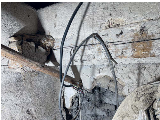
Obr. 19: Fara, schodiště na půdu, dvojice trámů zaniklého stropu a pozůstatky interiérové omítky síně, pohled ze severozápadu.
