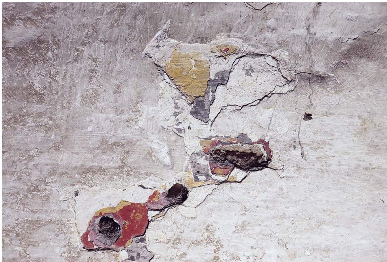
Obr. 9: Fara, sklepy, vrstvy omítek na západní stěně schodiště, stav 2023.
