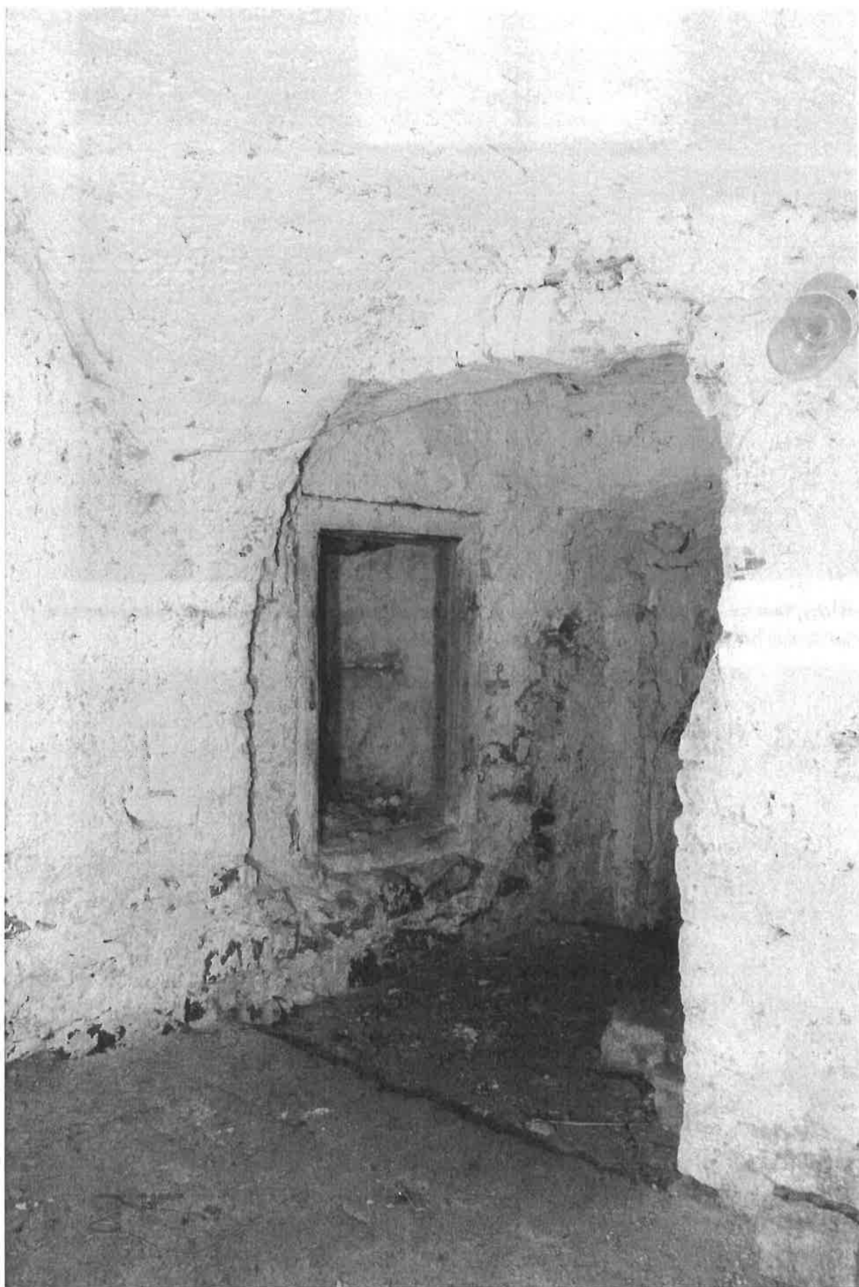
26) Popovičky, fara čp. 1, sklep, pohled z východního sklepa do podesty pod schody, směrem k západnímu sklepu, foto: Filip Facincani 2023
