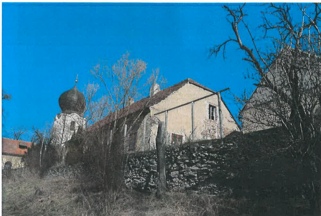
7) Popovičky, fara čp. 1, fara, pohled z jihozápadu, foto: Filip Facincani 2023
