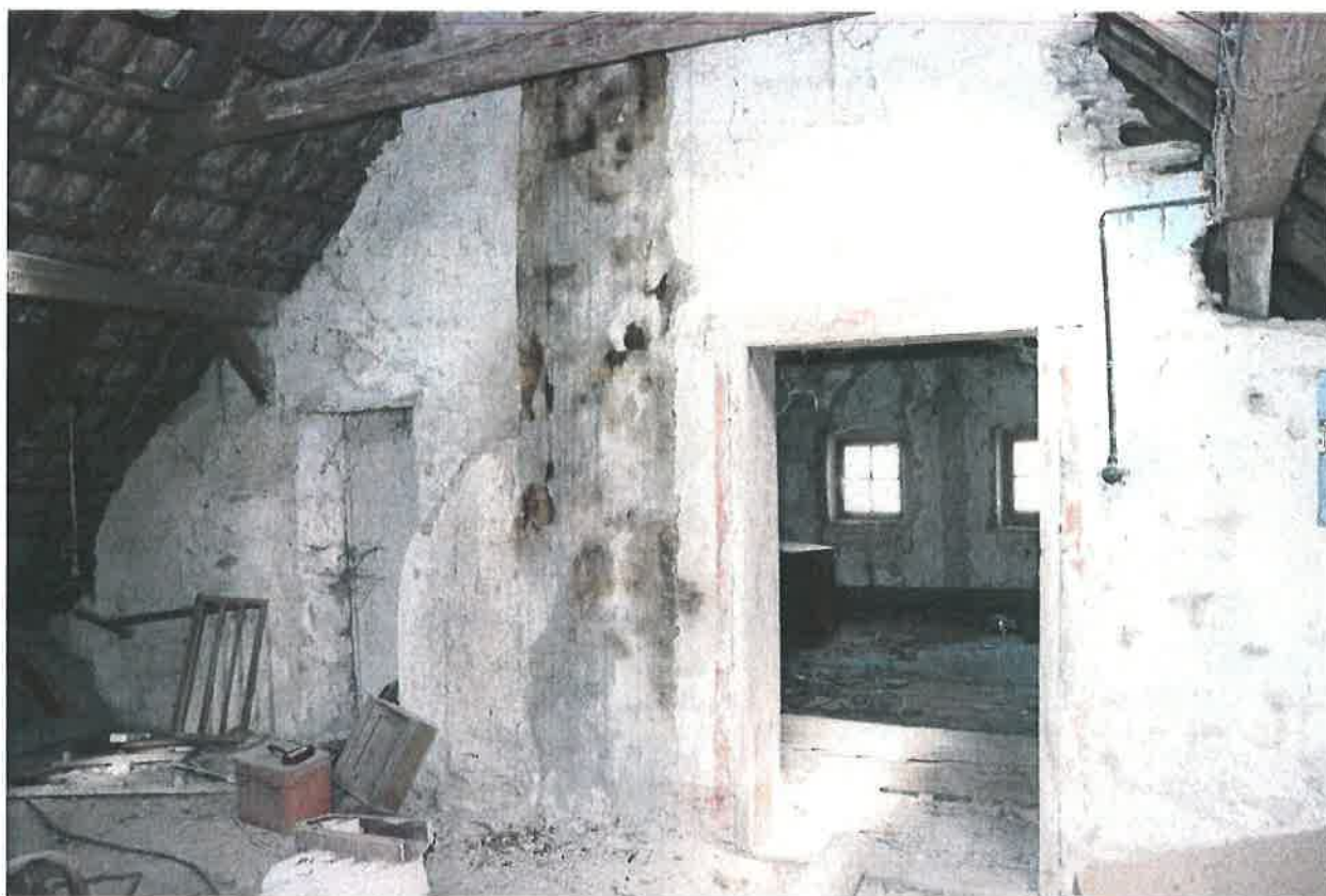
22) Popovičky, fara čp. 1, podkroví fary, příčka zaniklé obytné místnosti nad severním traktem přízemí, pohled z jihu, foto: Filip Facincani 2023
