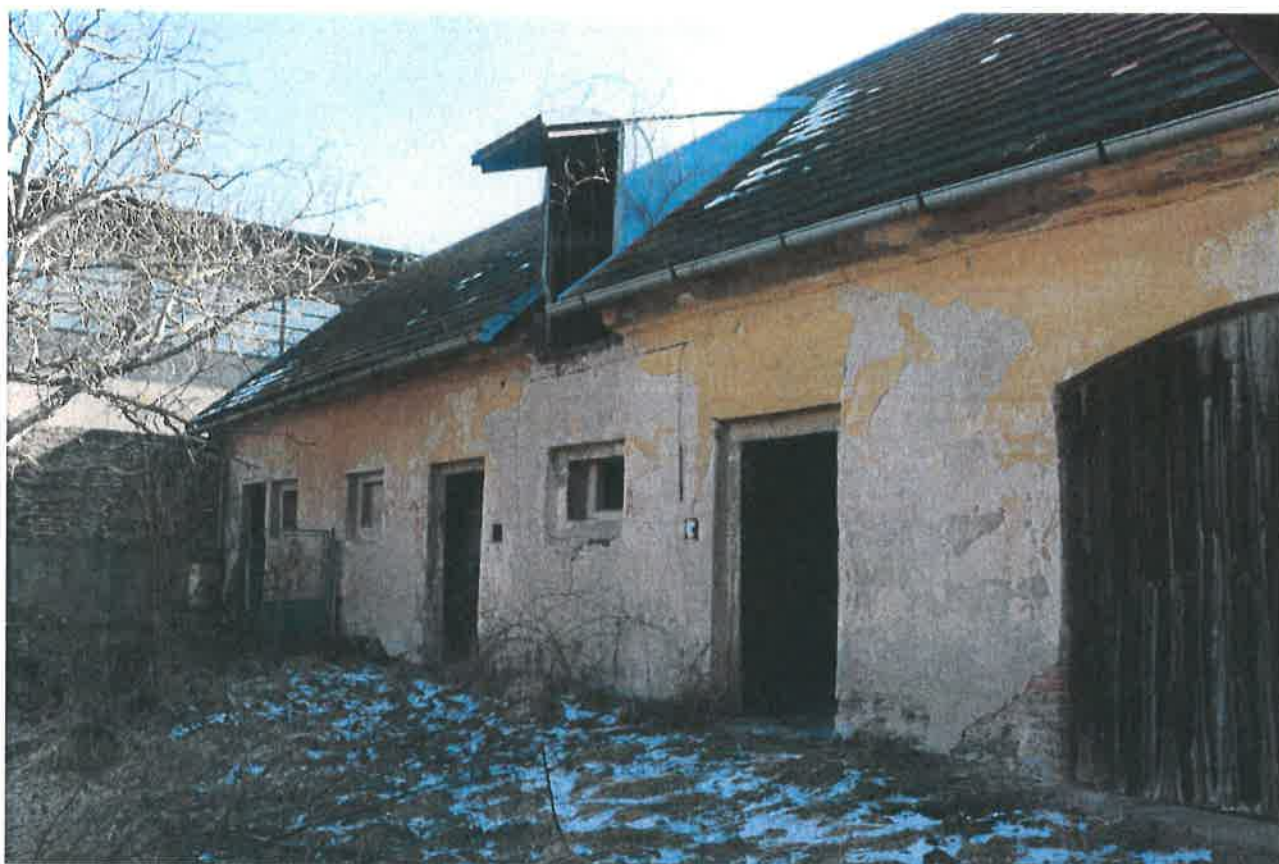
9) Popovičky, fara čp. 1, hospodářský objekt, pohled ze severozápadu, foto: Filip Facincani 2023
