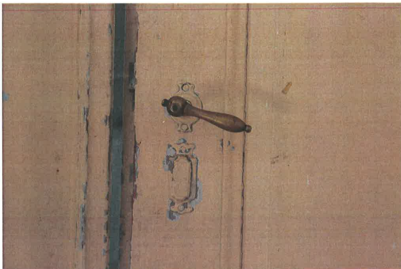
13) Popovičky, fara čp. 1, interiér fary, detail zachovaného dveřního kování I, foto: Filip Facincani 2023
