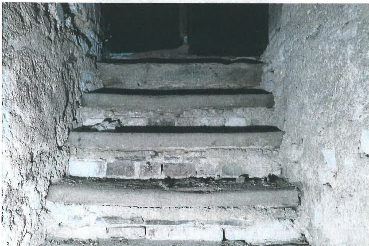
25) Popovičky, fara čp. 1, schody do sklepa, foto: Filip Facincani 2023
