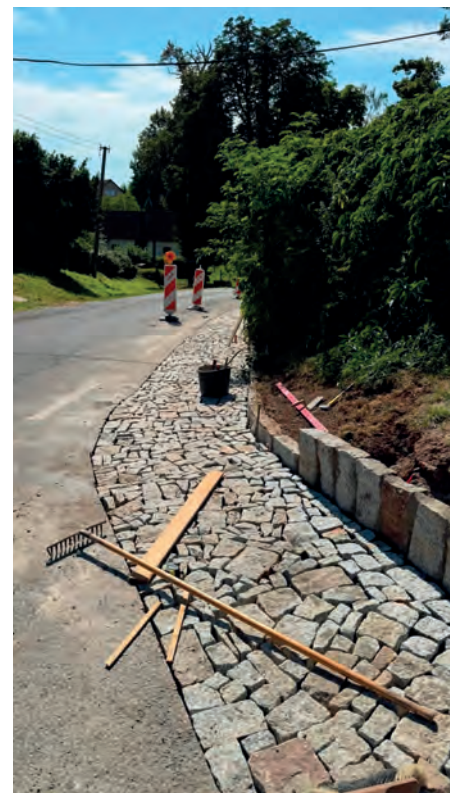
Dokončeno: Chodník kolem kostela a opěrná zeď
